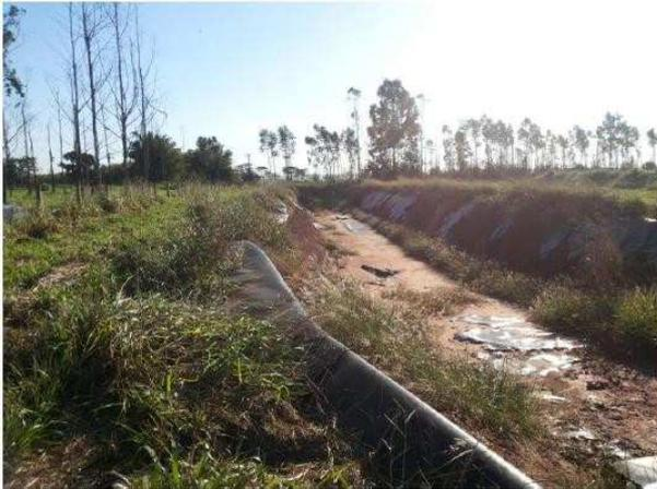
**Figura 43 – Manta de PEAD Avariada no Aterro Sanitário**
